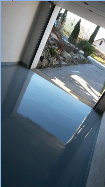
31.1.2018 - epoxidová podlaha - Farská budova - garáž
