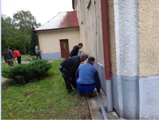
20.6.2020 - vonkajšia izolácia kostola - Vlkas
